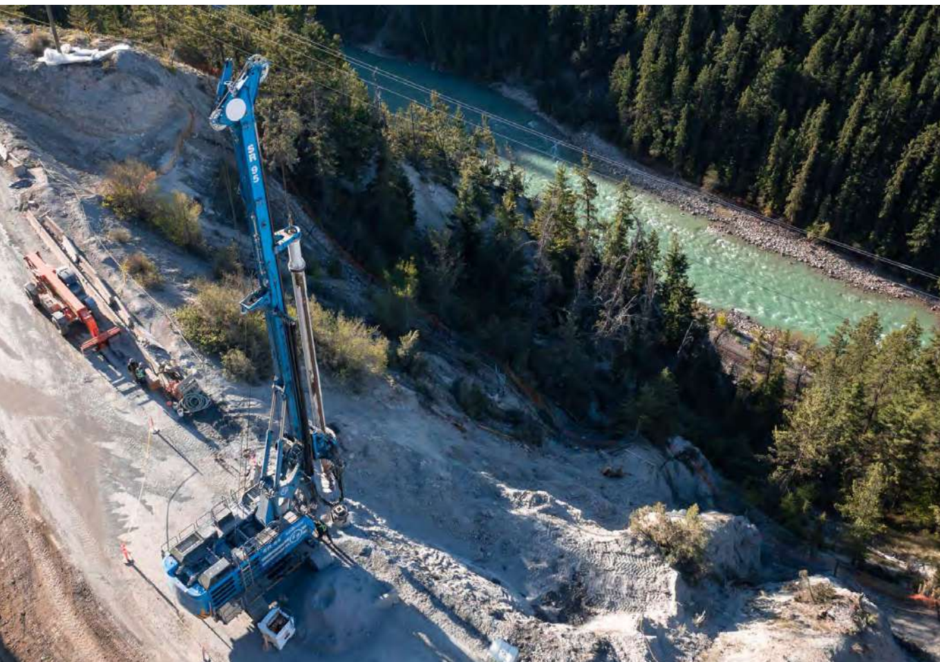
Attrezzatura Soilmec della linea Bluetech, in cantiere.
