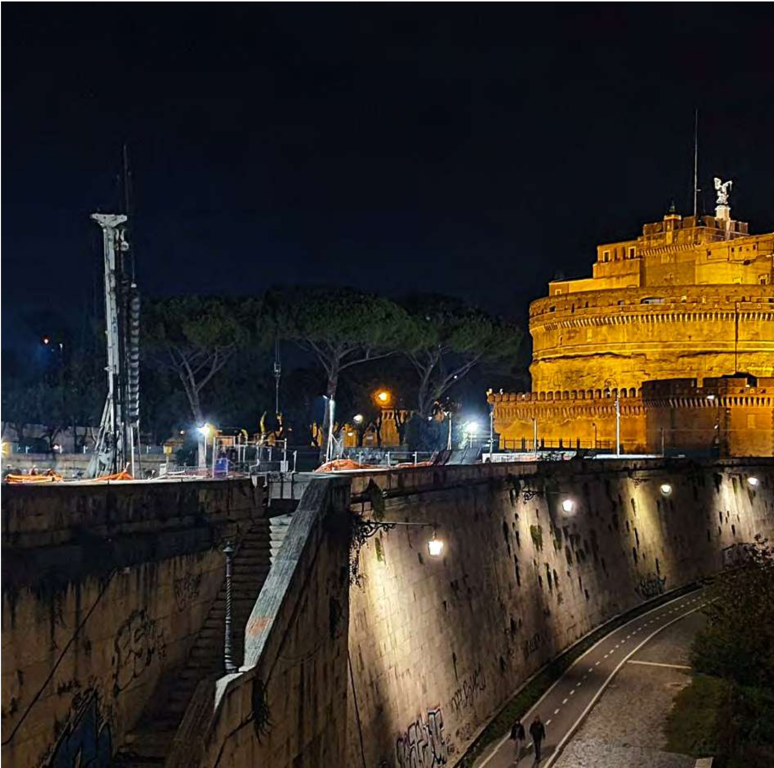
Cantiere Trevi per Metro Roma, linea C | Roma, Italia
